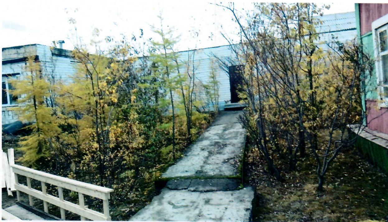
Запасной выход со стороны галереи
